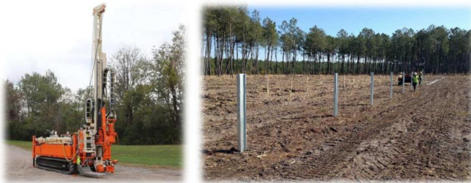
Figure 3 : Ancrage au sol par pieux battus
